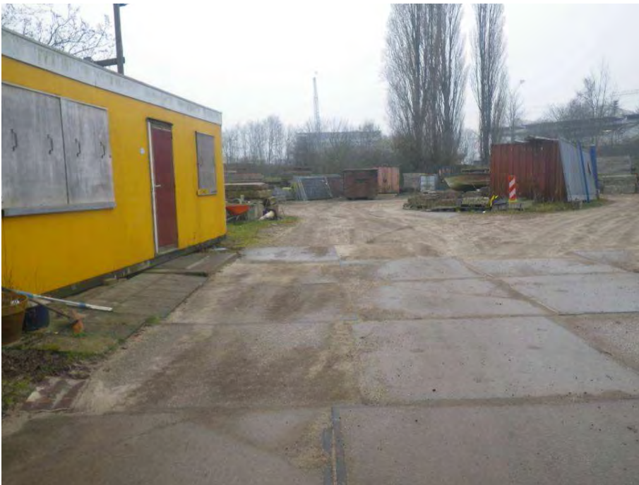
Foto 4: Keten en opslagmaterialen
